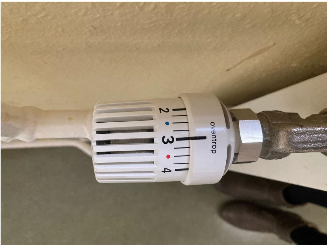
Trotz Bemühungen in der Öffentlichkeitsarbeit kam es immer wieder vor, dass Heizventile auf Stufe 4 oder 5 eingestellt wurden, obwohl eine Temperatur von 20 Grad Celsius im Klassenzimmer völlig ausreichend ist, was Stufe 3 für das Heizventil entspricht.
